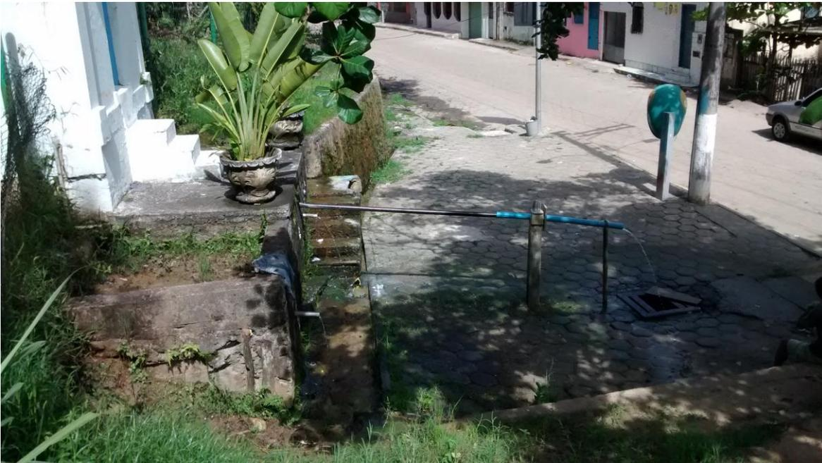
*Foto 12 - Vista do reservatório abaixo dos vasos e da bica em ferro fundido e pvc, com lançamento na grelha*
